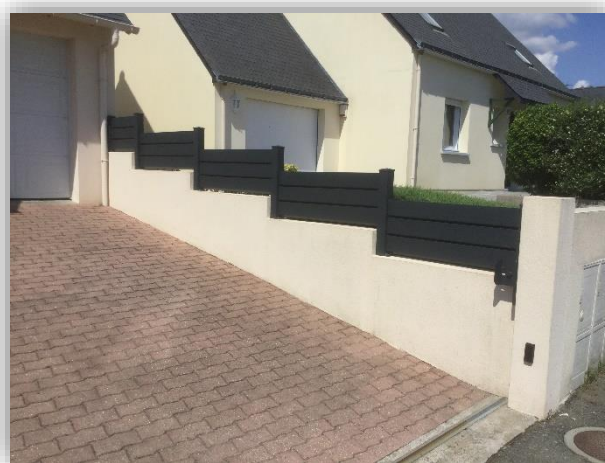
Clôture sur muret avec platine en pare-vue aluminium. Pose en escalier. Ce type de clôture est ajourée en biais donc laisse passer le vent mais pas la visibilité.
