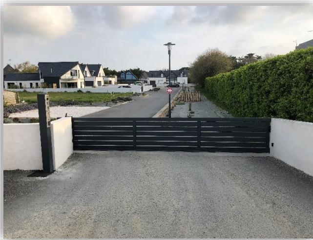
Portail coulissant de type MISTRAL en lames de 100 mm horizontales, ajourées.
