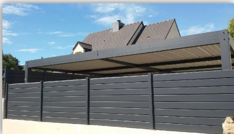
Clôture sur muret avec platine en pare-vue aluminium. Ce type de clôture est ajourée en biais donc laisse passer le vent mais pas la visibilité.
