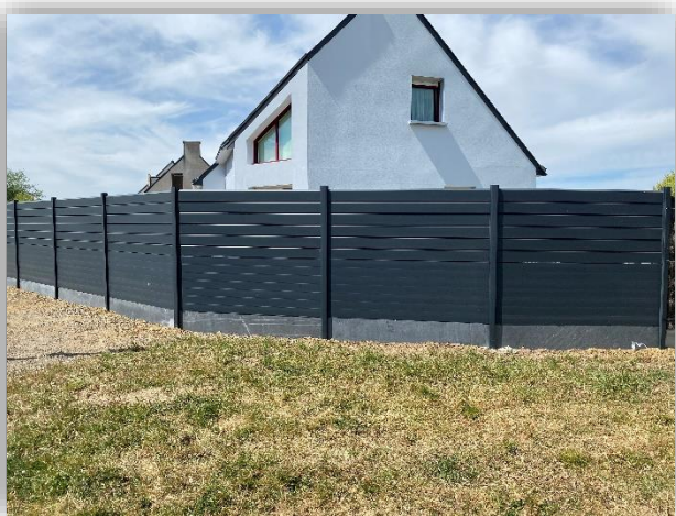
Clôture scellée dans le sol en pare-vue aluminium avec un soubassement en palis d'ardoise. Ce type de clôture est ajourée en biais donc laisse passer le vent mais pas la visibilité.
