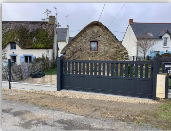
Portail coulissant de type DALU en lames verticales de 100 mm avec une partie haute ajourée et une partie basse pleine.
