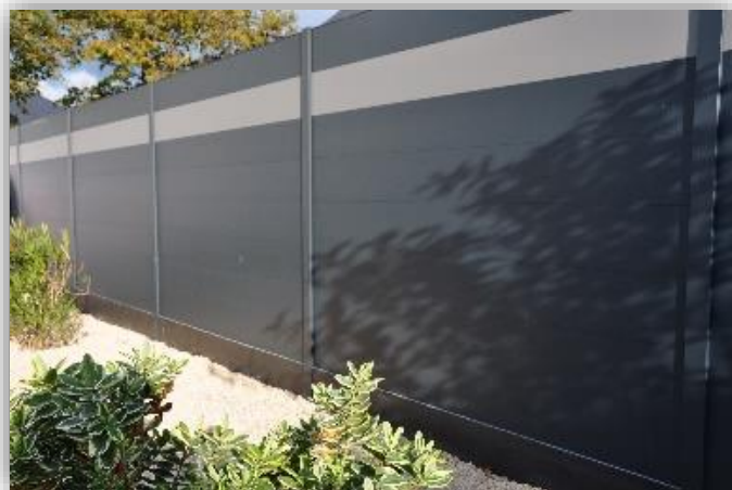
Clôture scellée dans le sol en lames de 200 mm jointives horizontales avec une lame de couleur différente et un soubassement en palis d'ardoise.
